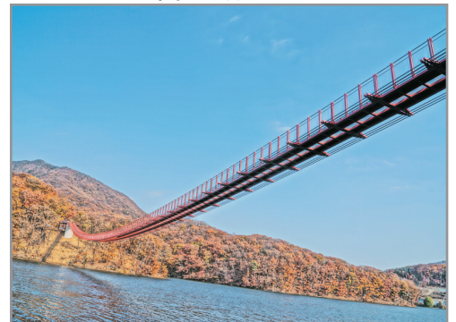
馬場湖水吊索橋
