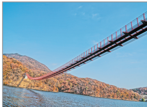
馬場湖水吊索橋
