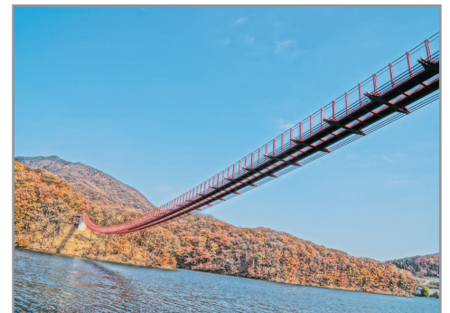
馬場湖水吊索橋
