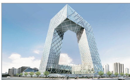
CCTV中央電視台
