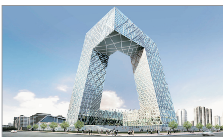
CCTV中央電視台
