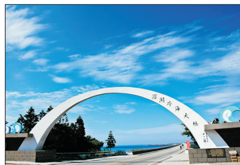
澎湖跨海大橋
