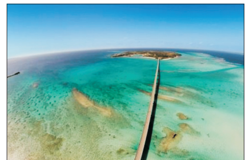
池間大橋(宮古島，日本)
