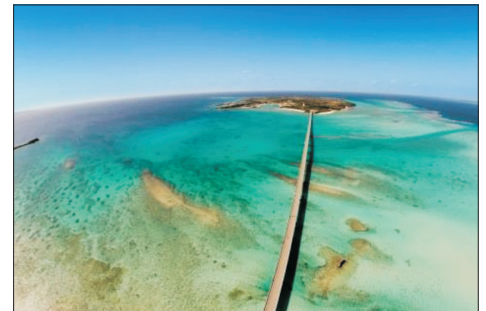
池間大橋(宮古島，日本)
