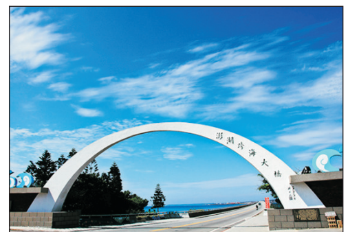
澎湖跨海大橋
