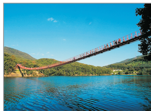
馬場湖水吊索橋
