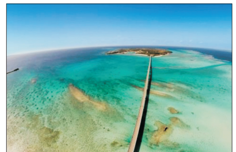
池間大橋(宮古島, 日本)
